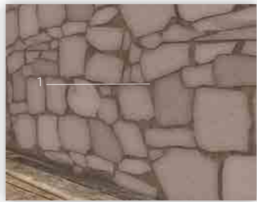
Ristilatura dei giunti.
